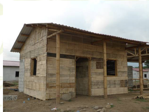
36. Estructura lista para aplicación de cemento
