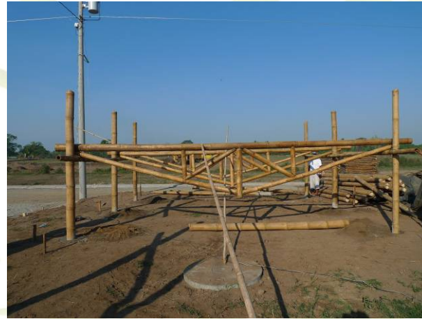
12. Colocación de Tijeras
