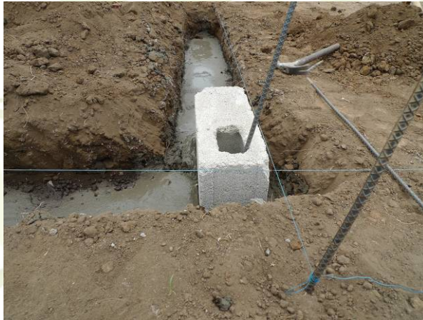
21. Levantado de cimientos
