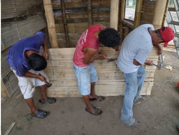
33. Colocación de Esterilla
