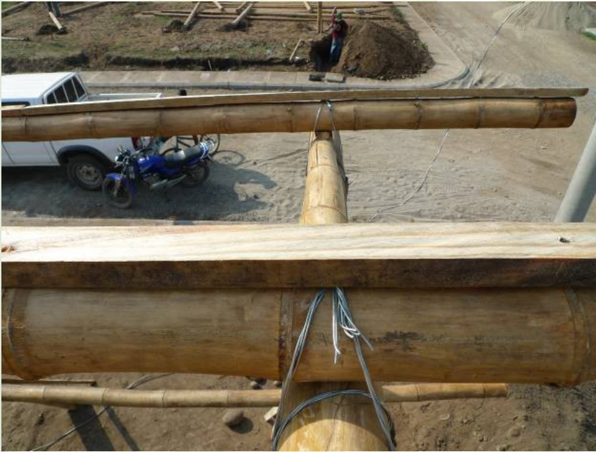
19. Colocación de madera
