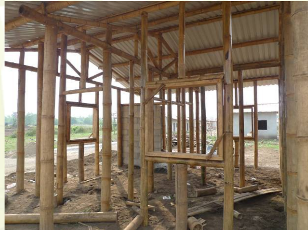
32. Colocación de postes en general
