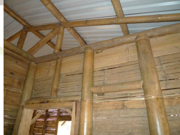
34. Acabado final por dentro
