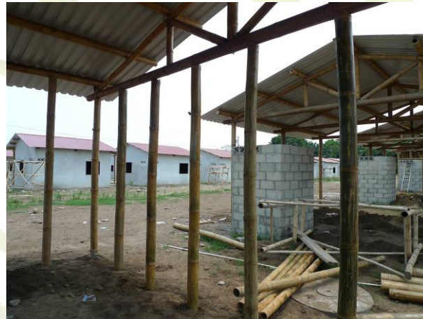
30. Colocación de postes
