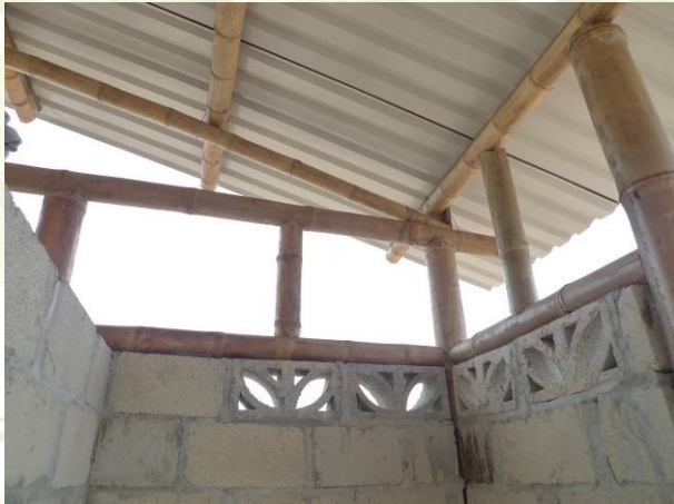
31. Colocación de postes en baño
