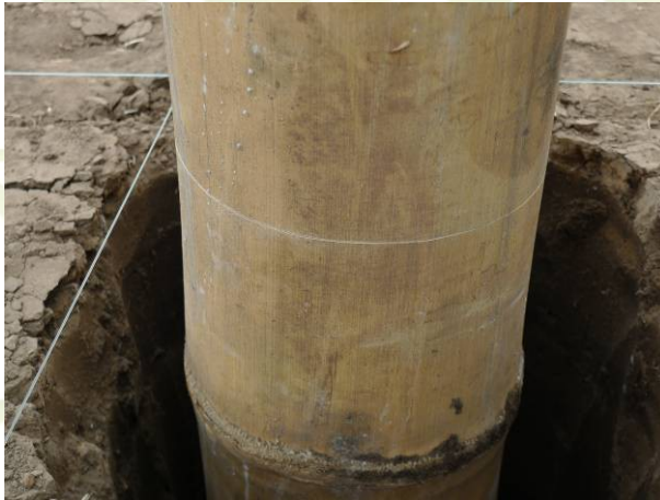
7. Anclaje del poste
